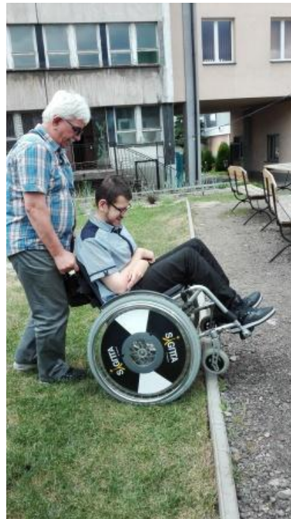
WYSTAJĄCY KRAWĘŻNIK PRZY WEJŚCIU DO OGRODU SPOŁECZNEGO
