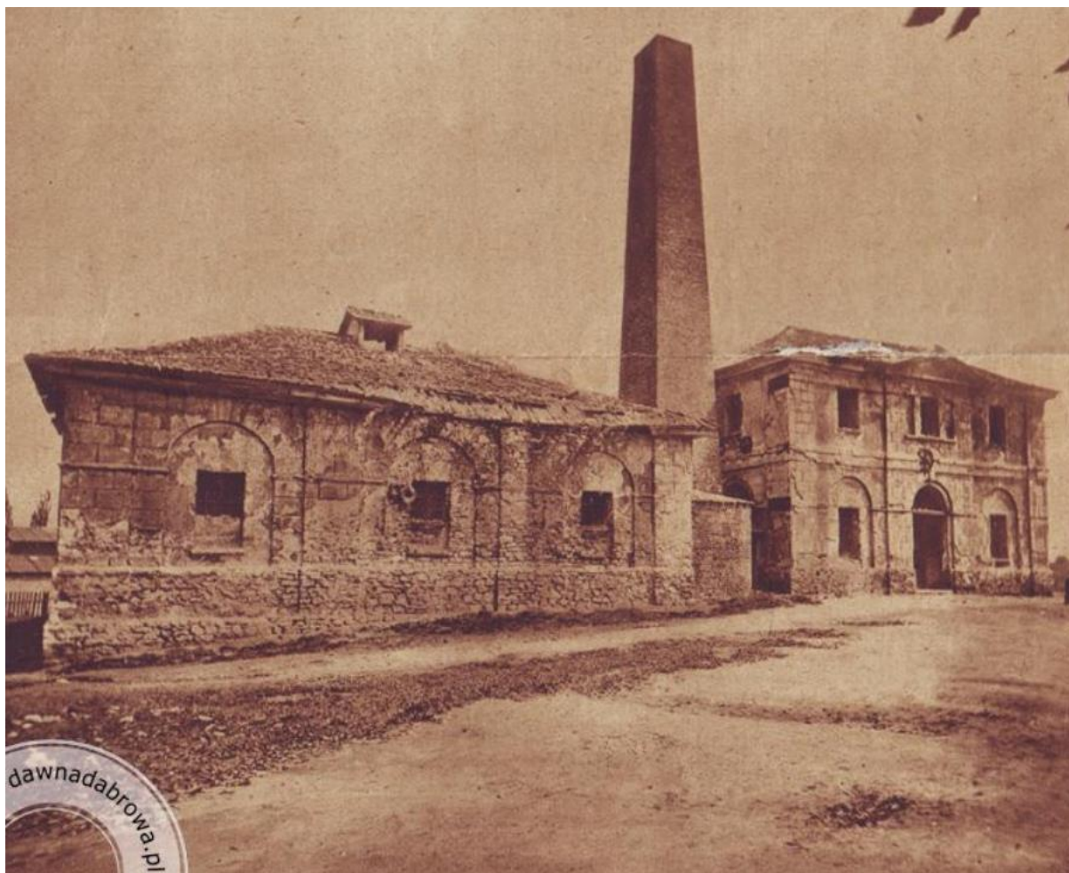
Zdj.9 Szyb wodny w miejscu Resursy.
