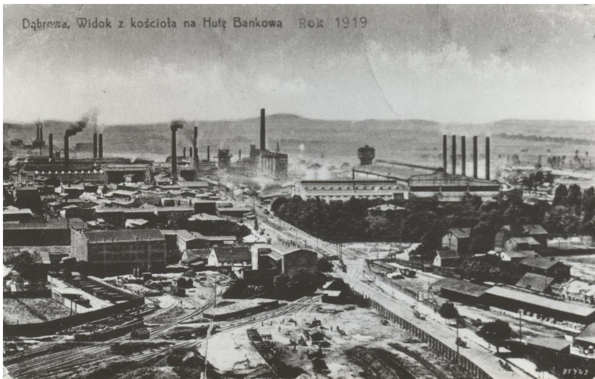
Zdj.61 Fotografia węzła kolejowego
