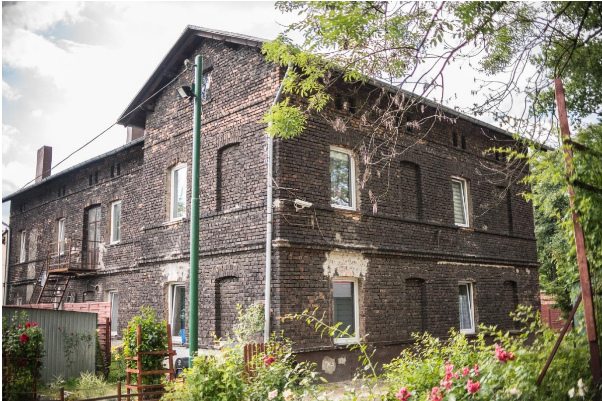
Zdj.54 Fotografia kamienicy Jaworskich Autor: Bartosz Lorens
