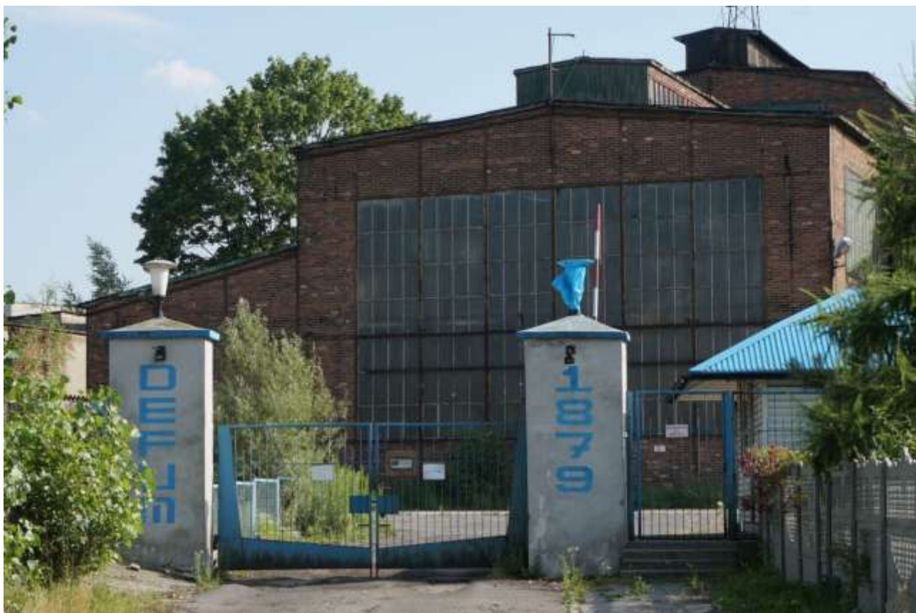
Zdjęcie 1. Tereny po byłym zakładzie produkcji maszyn DEFUM, ul. Kolejowa (Autor: Adam Polko)
