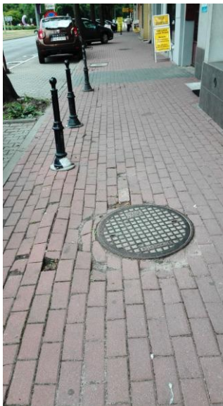
UL. SOBIESKIEGO- USZKODZONA NAWIERZCHNIA CHODNIKA
