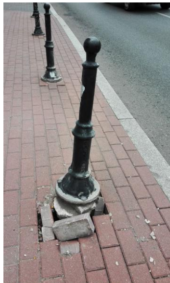
UL. SOBIESKIEGO- USZKODZONA NAWIERZCHNIA CHODNIKA
