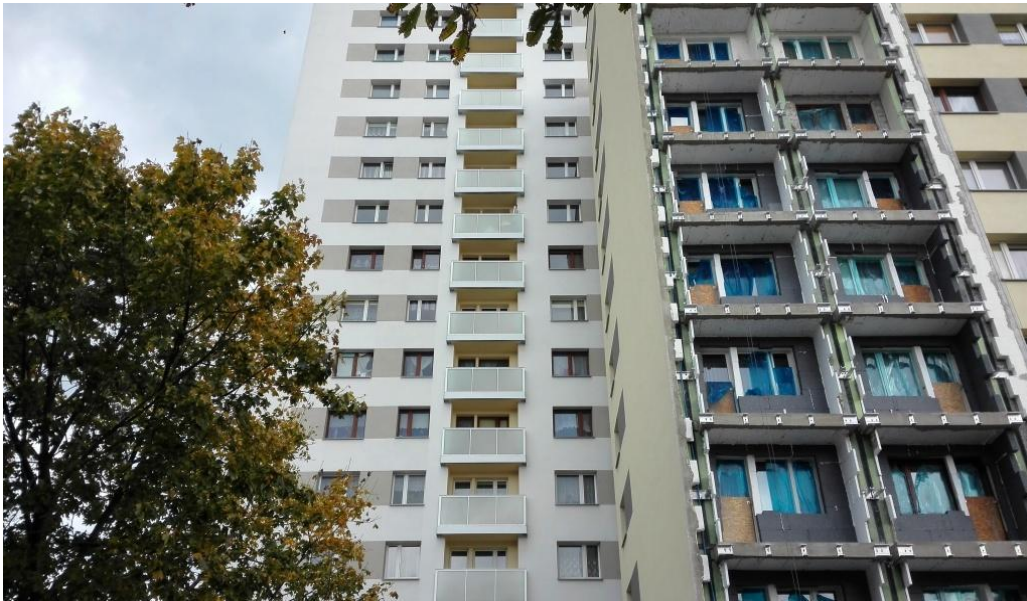
UL. H.SIENKIEWICZA- NOWE ŁADNE ELEWACJE BUDYNKÓW
