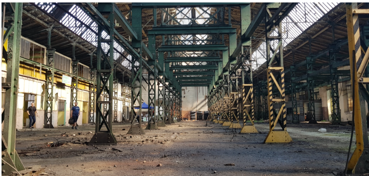
Fot. 3 - Budynek H3 - wnętrze
