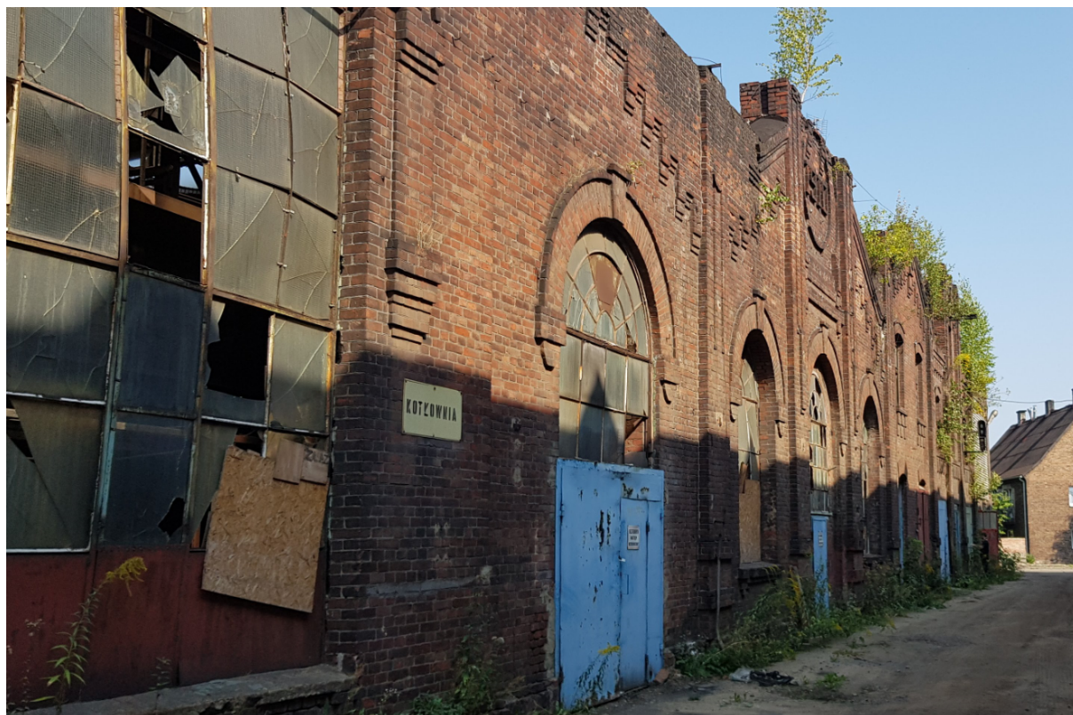
Fot. 5 - Budynek H7 - elewacja zewnętrzna
