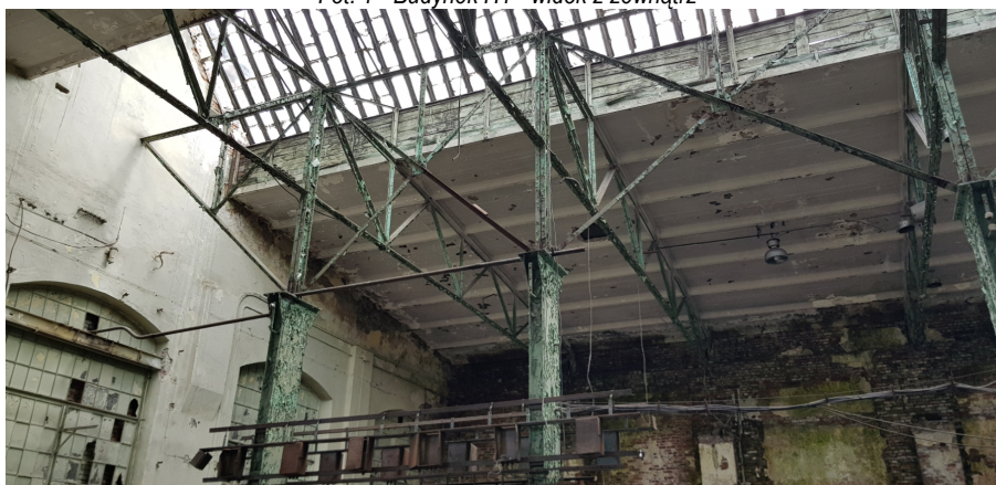
Fot. 2 - Budynek H1 - widok dachu od wewnątrz
