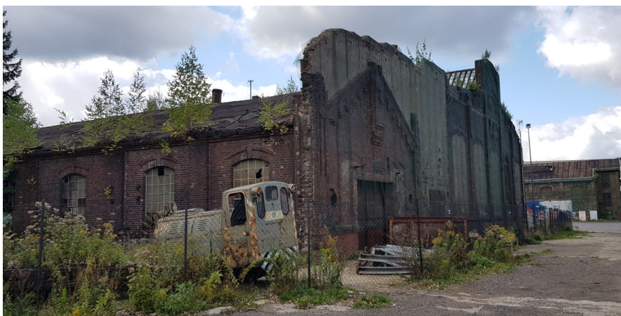
Fot. 1 - Budynek H1 - widok z zewnątrz
